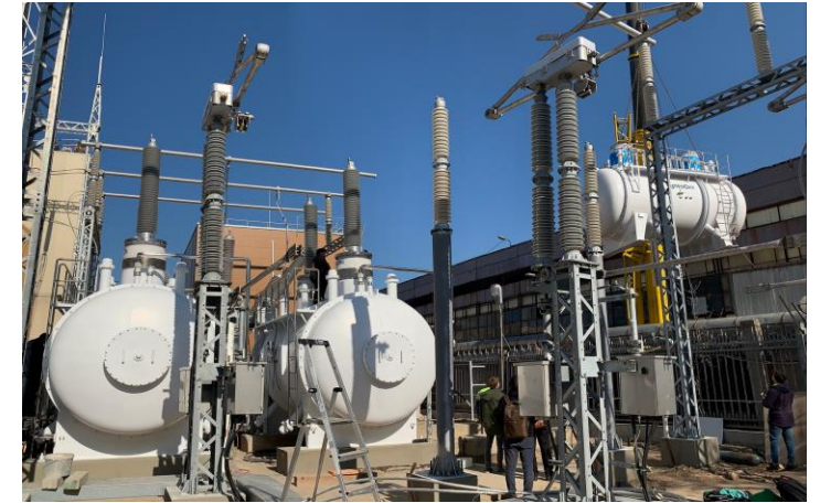
Anwendung ins Moskau: 220 kV, 1200 A
